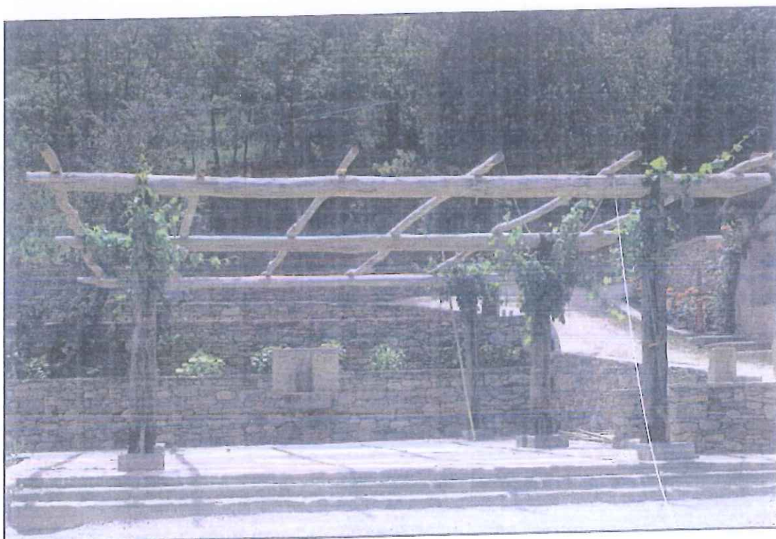
scatto 2 - vista del pergolato dal prospetto nord
